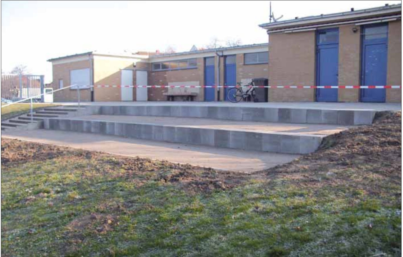
Eine kleine Stehtribüne entstand während der Wintermonate vor dem Funktionsgebäude.
